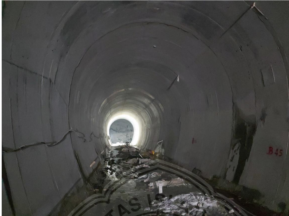
Gambar Lampiran 3: Dinding Terowongan yang sudah Jadi
