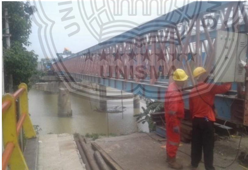
Foto : Pengecekan dan pemasangan launcher Sumber : Dokumtasi pribadi, 2020
