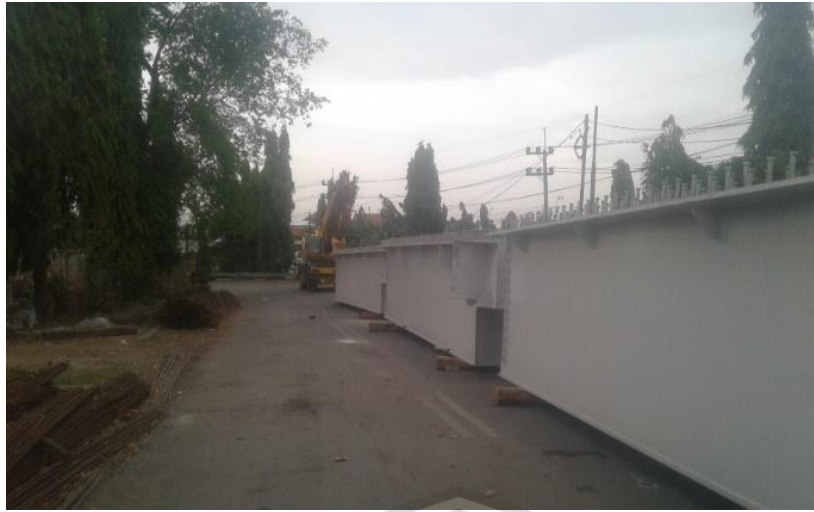
Foto : Persiapan pemasangan stell box girder Sumber : Dokumtasi pribadi, 2020
