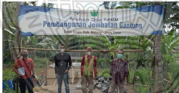
Gambar 1. Proses pembangunan jembatan gantung
