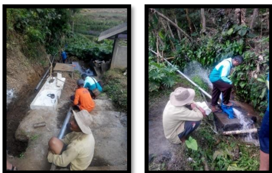
Gambar 4. Proses instalasi pipa dan pompa
