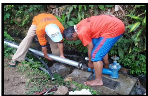
Gambar 6. Pelatihan instalasi pompa dan pipa.
