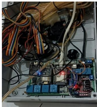
w) Pemasangan Komponen Boks Panel
