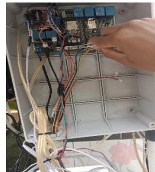
x) Penyambungan Komponen listrik Pada Boks Panen
