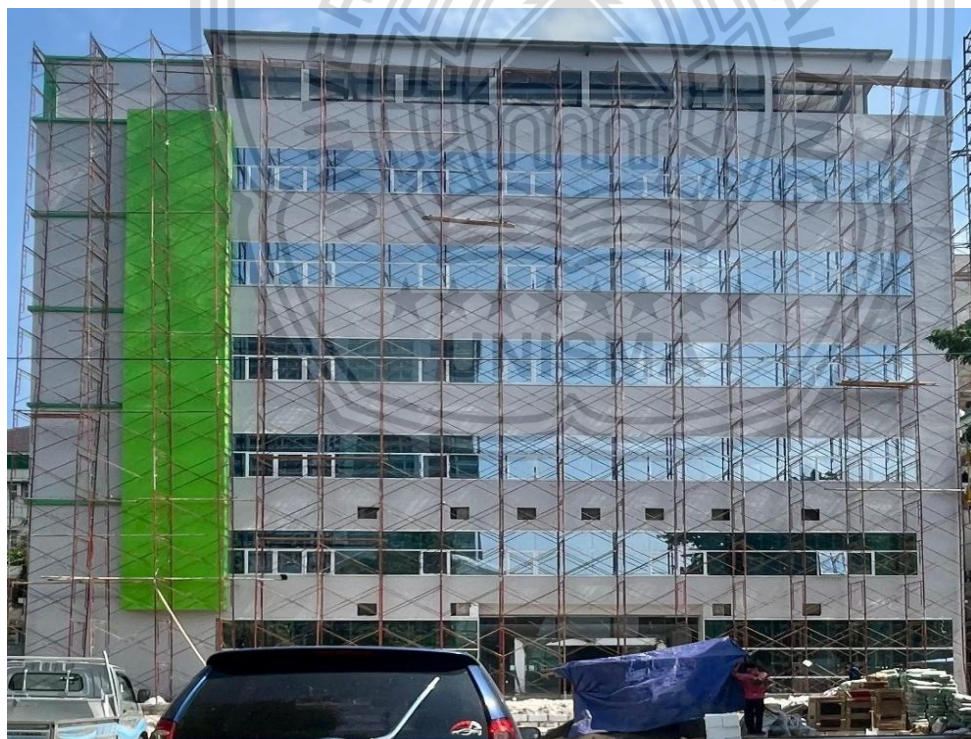
Gambar 2 Progres Pembangunan Gedung RSUD Ibnu Sina Gresik Sumber : (Dokumentasi Pribadi, 2024)
