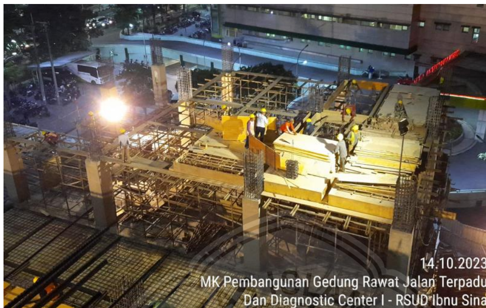
Gambar 1 Progres pembangunan Gedung RSUD Ibnu Sina Gresik Sumber : (Dokumentasi Internal Proyek, 2023)
