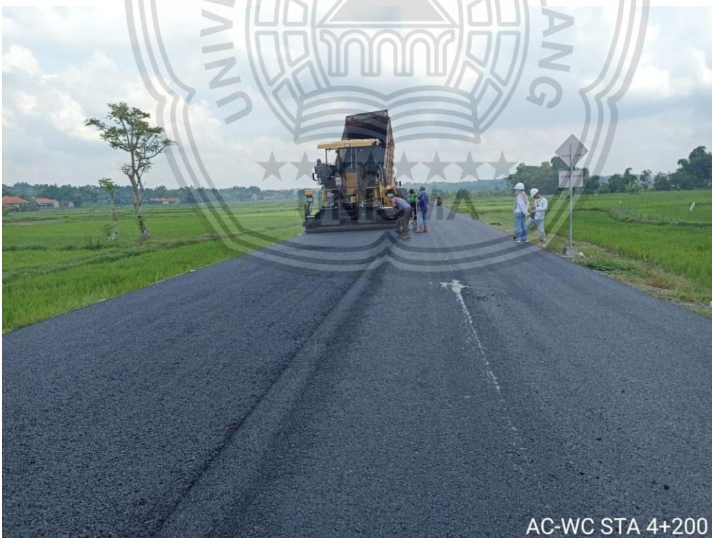
Gambar 4. Finishing Aspal Sumber : Dokumentasi Pribadi,2022
