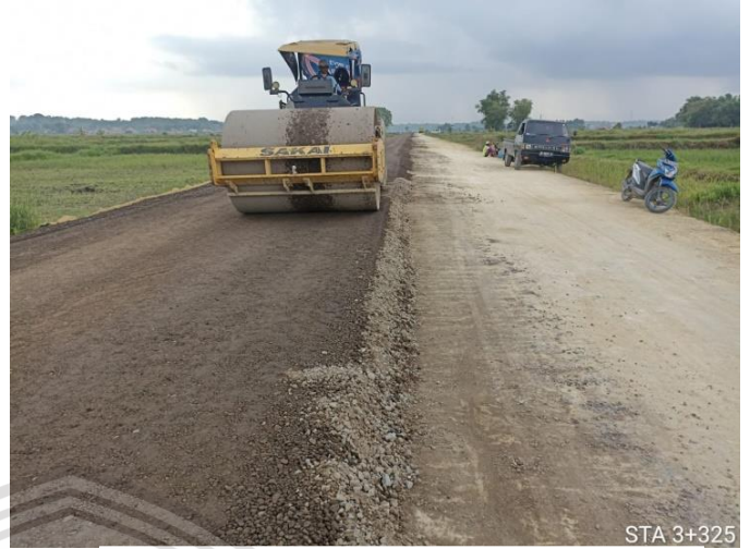
Gambar 3.3 Pemadatan Sta 3+325 Sumber: Dokumentasi pribadi, 2022
