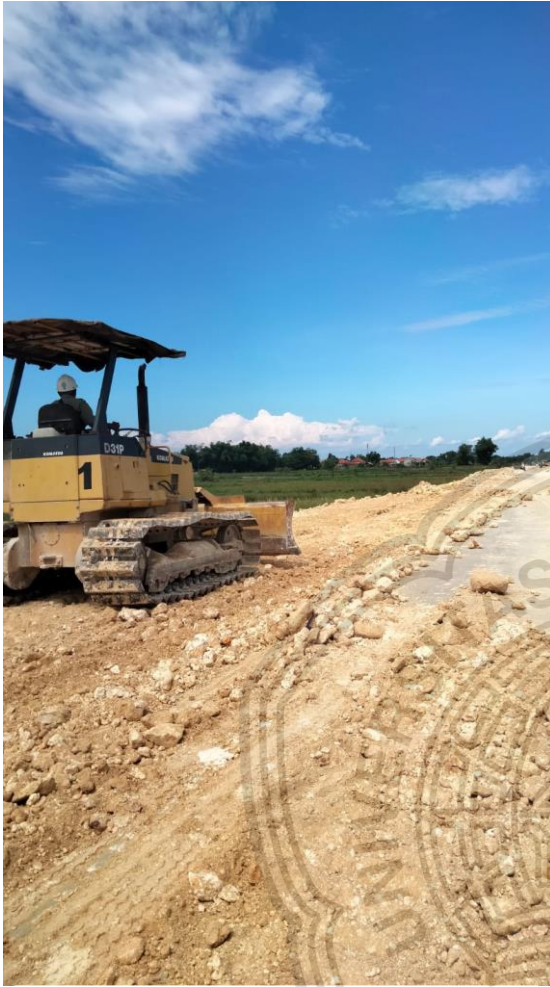
Gambar 1. Pemerataan agregat Sumber : Dokumentasi Pribadi,2022
