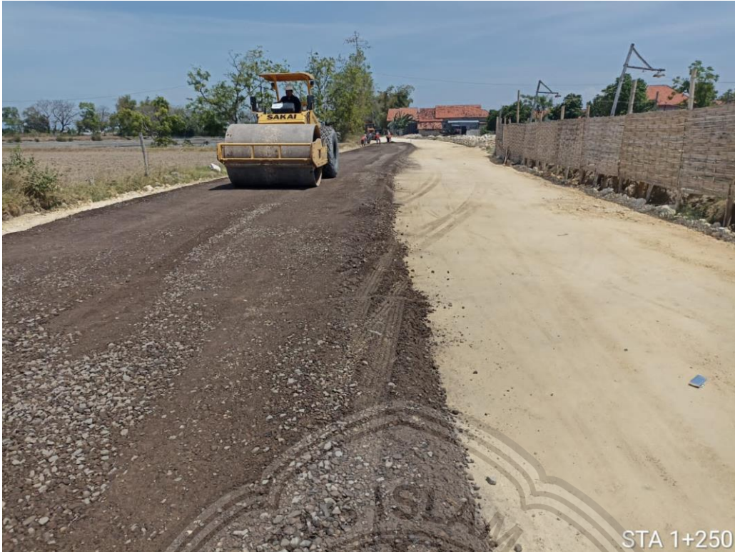
Gambar 3. Pemasangan Tanah Sumber : Dokumentasi Pribadi,2022
